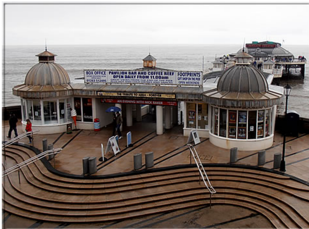
Am Pier von
