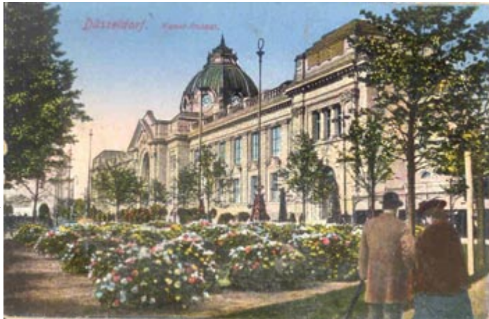
Blick auf den alten Kunstpalast (Foto 1)
